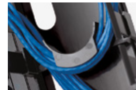
Monter l'enrouleur de mou sur les peignes du tube pour gérer l'excès de câble.
